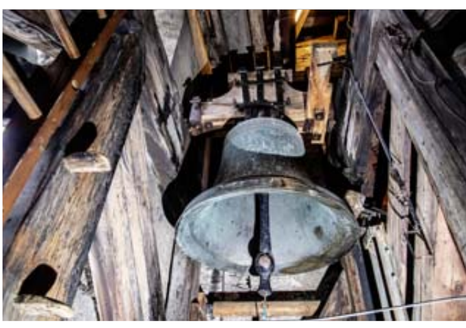
EN PIQUÉ Au-dessus de la cloche, à droite, on aperçoit la pédale qui permet de la faire balancer avec le pied.
